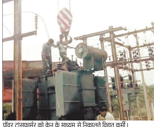
पावर ट्रांसफार्मर को क्रेन के माध्यम से निकालते विद्युत कर्मी।
